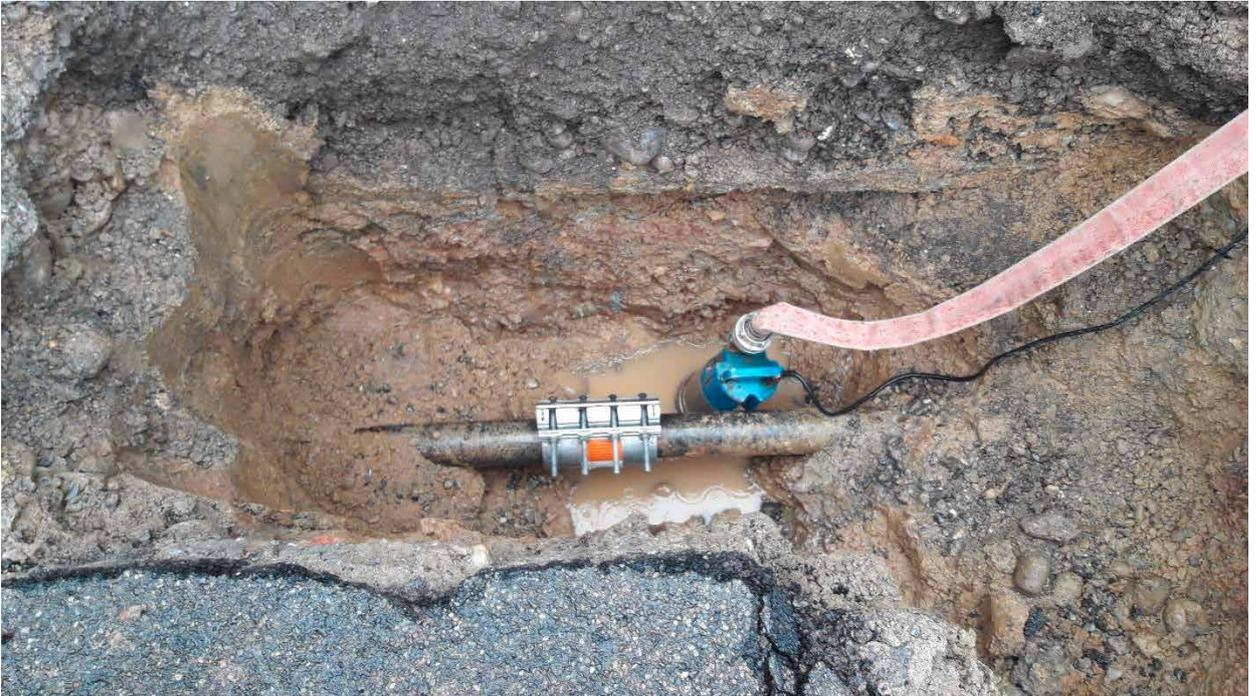
Reparatur mit einer Rohrbruchschelle
